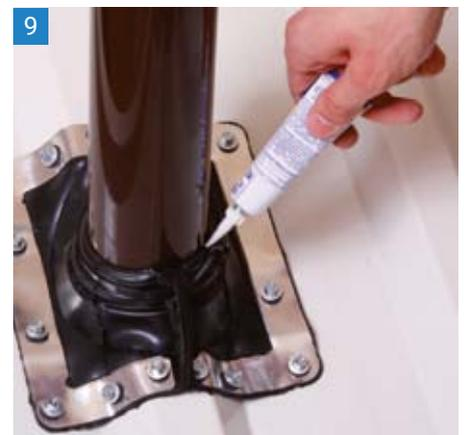
9 Zusätzliches Dichtmittel kann zwischen der Manschette und dem Rohr aufgetragen werden. Bei Bedarf anwenden.
