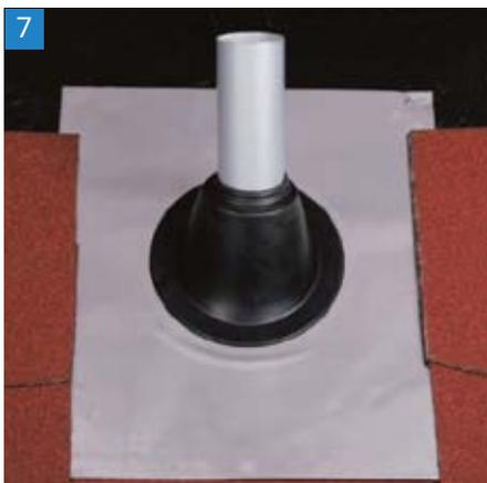
7 Befestigen Sie zunächst die Dachpappen an den beiden Seiten des Master Flash®.
