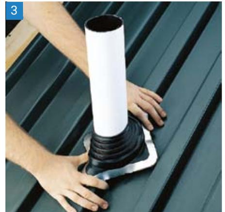
3 Passen Sie den Master Flash® durch Druck an das Profil oder an Unebenheiten an. Ein stumpfes Werkzeug hilft dabei, die Abdeckung in enge Dachwinkel zu drücken.
