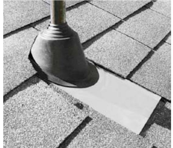
Diese Manschette wird bei flachen Dachabdeckungsarten wie Dachpappe, Zement- oder Keramik-Dachpfannen eingesetzt. Die Grundplatte besteht aus acrylbeschichtetem Blei, wodurch eine einfache Anpassung an unterschiedlichste Dachabdeckungen möglich ist.
