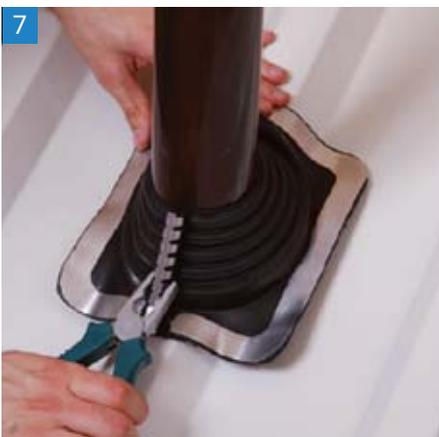
7 Drücken Sie die Klammer mit Hilfe eines Werkzeugs zusammen.
