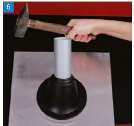
6 Befestigen Sie die Metallbasis am Dach.
