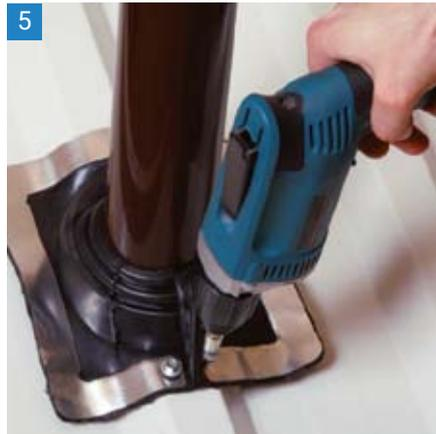
5 Verwenden Sie Schrauben, um die Dichtung fertigzustellen. Der Abstand der Schrauben darf nicht größer als 1,5" (38 mm) sein.
