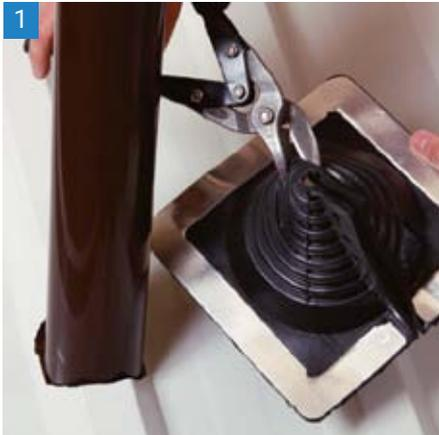
1 Wählen Sie einen geeigneten Master Flash® Retrofit mit einem Rohrbereich, der über das benötigte Maß hinausgeht. Beachten Sie bei Bedarf die auf dem Master Flash® vorhandenen Abstufungen, um eine Öffnung zu schneiden, die 20-30% kleiner als der Rohrdurchmesser ist.
