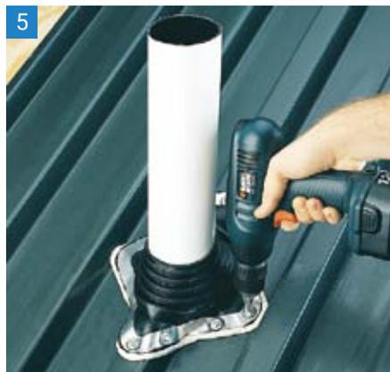
5 Verwenden Sie Schrauben, um die Dichtung fertigzustellen. Der Abstand der Schrauben darf nicht größer als 1,5" (38 mm) sein.
