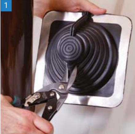
1 Wählen Sie einen geeigneten Master Flash® Multi mit einem Rohrbereich, der über das benötigte Maß hinausgeht. Beachten Sie bei Bedarf die auf dem Master Flash® vorhandenen Abstufungen, um eine Öffnung zu schneiden, die 20-30% kleiner als der Rohrdurchmesser ist.
