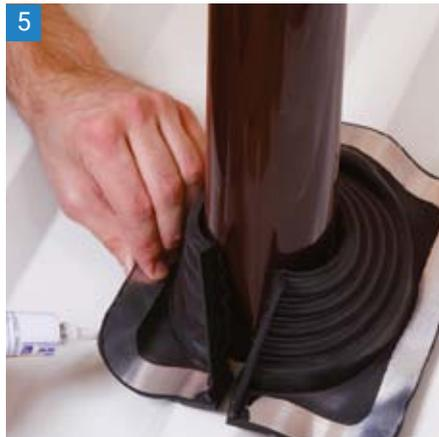
5 Tragen Sie das Dichtmittel zwischen Master Flash® und dem Dach, sowie an der oberen Öffnung der Manschette, auf.
